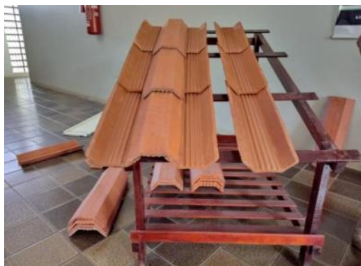
Figura 9 - Colocação da telha (posição da capa)
