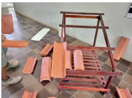
Figura 5 - Colocação da primeira telha (posição canal)
