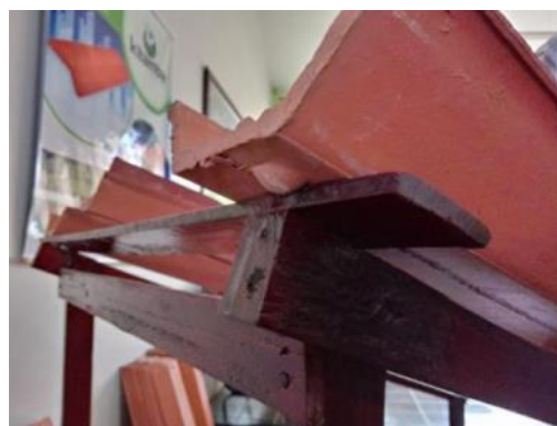
Figura 8 - Demonstração do encaixe do pino no ripamento
