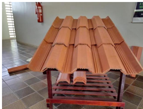
Figura 10 - Finalização da montagem das telhas
