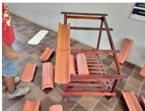
Figura 6 - Colocação da segunda telha (posição canal)
