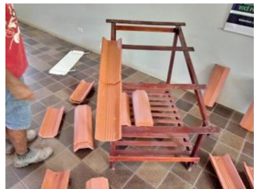
Figura 6 - Colocação da segunda telha, garantindo o recobrimento longitudinal mínimo de 75mm
