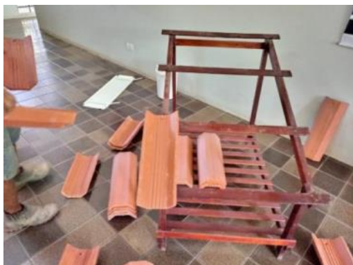
Figura 5 - Colocação da primeira telha (posição canal)
