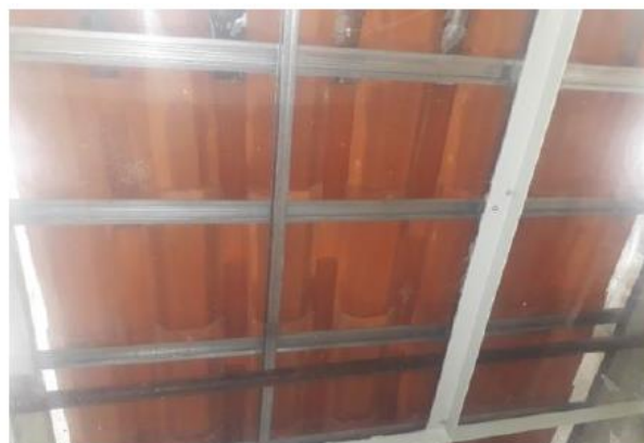
Figura 18 – Execução de ensaio de estanqueidade à água
