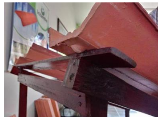
Figura 8 - Demonstração do encaixe do pino no ripamento
