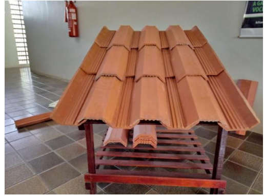
Figura 10 - Finalização da montagem das telhas
