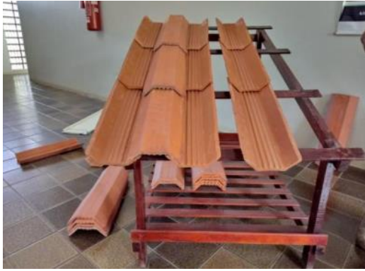
Figura 9 - Colocação da telha (posição da capa)
