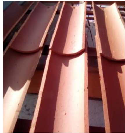
Figura 6 - Colocação da segunda telha, garantindo o recobrimento longitudinal mínimo de 70mm
