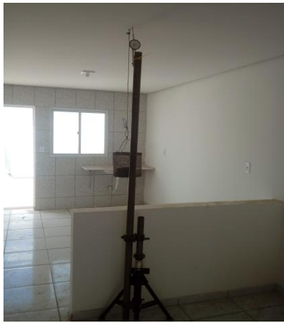
Figura 11 – Realização do ensaio de resistência de peças suspensas em forro de gesso
