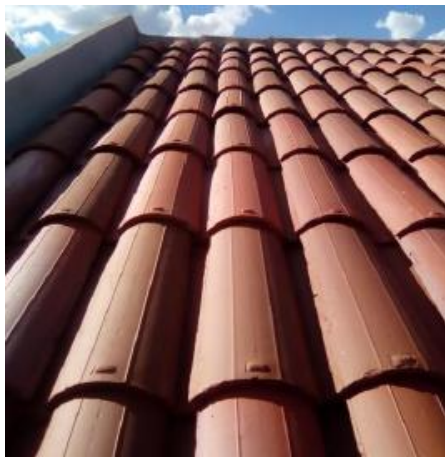
Figura 9 - Colocação da telha (posição da capa) e finalização da montagem
