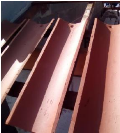
Figura 5 - Colocação da primeira telha (posição canal)
