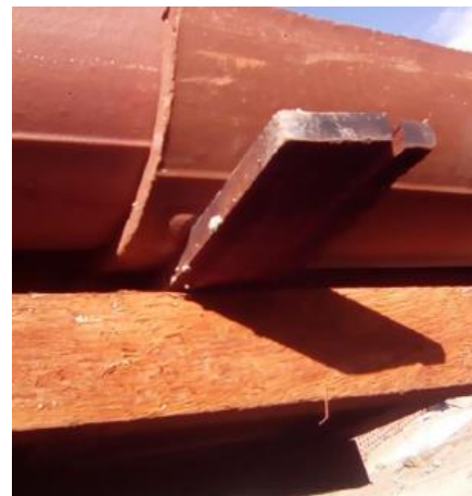
Figura 8 - Demonstração do encaixe do pino no ripamento
