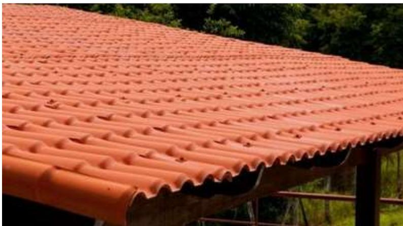
**Figura 4 – Telhado constituído de telhas cerâmicas tipo romana**
