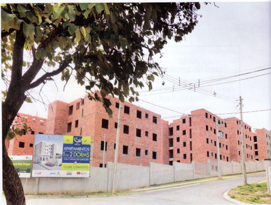
Obra da Cataguá Construtora e Incorporadora em Piracicaba (SP) usa alvenaria estrutural com blocos cerâmicos em casas
