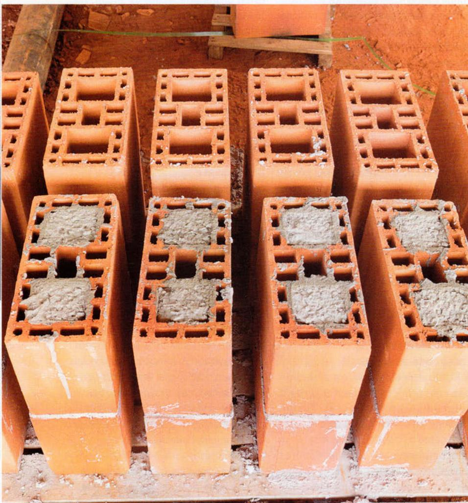
Blocos cerâmicos usados em sistema de alvenaria estrutural
