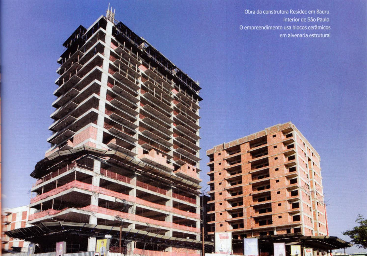
Obra da construtora Residéc em Bauru, interior de São Paulo. O empreendimento usa blocos cerâmicos em alvenaria estrutural
